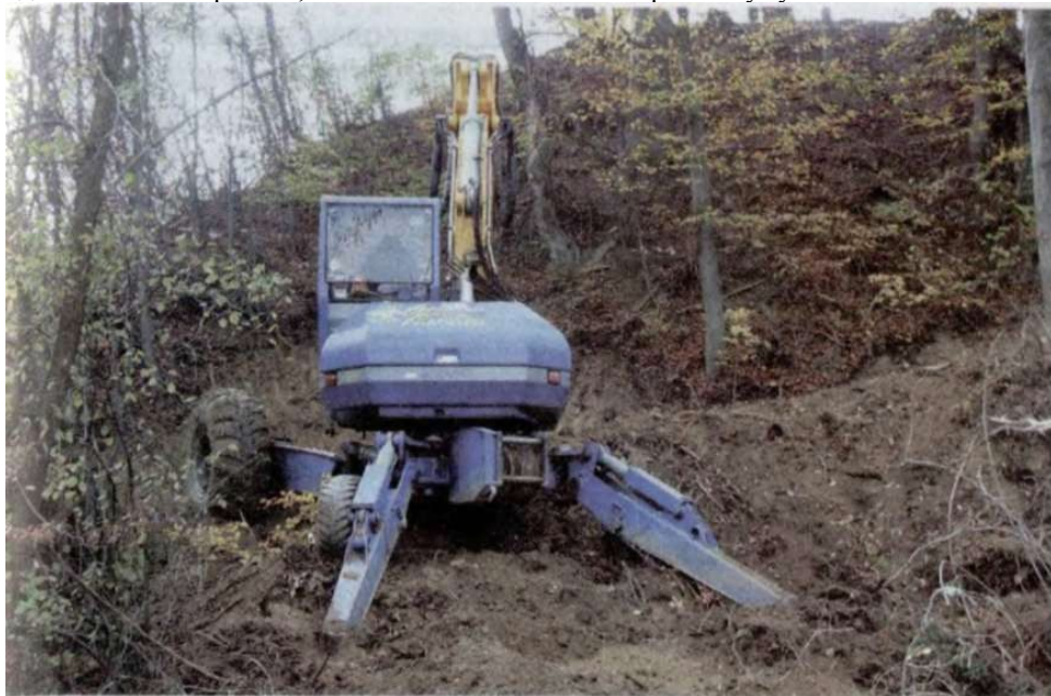
Экскаватор «паук» позволяет работать даже на непроходимом участке
