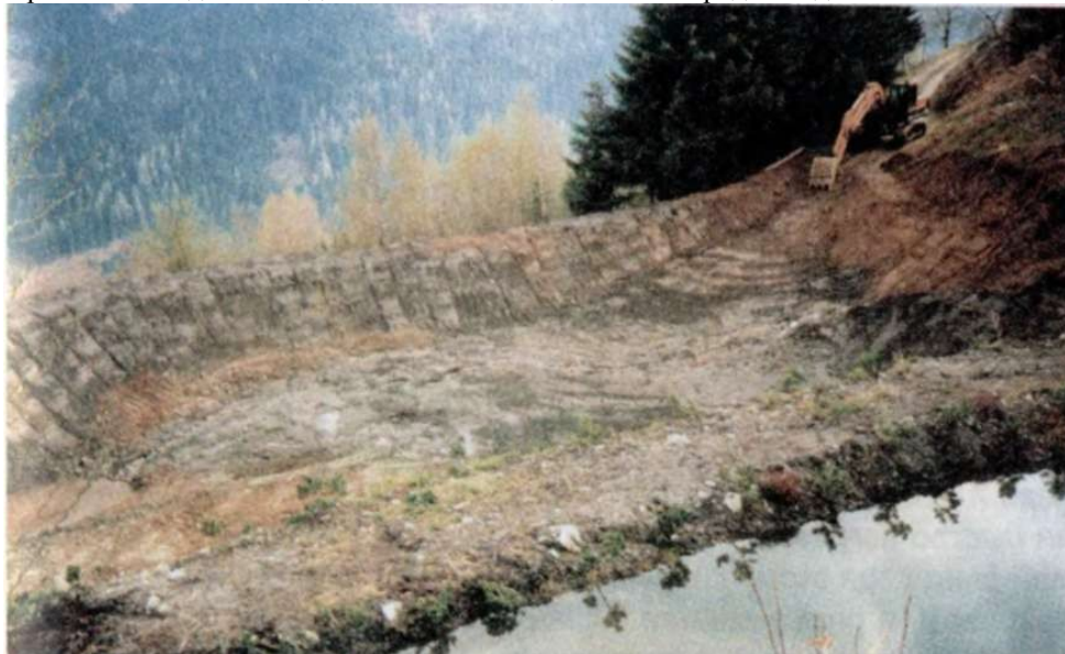
Закончено строительство пруда в Краметерхофе
